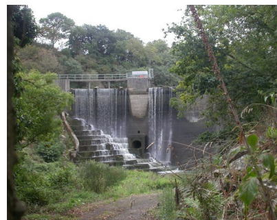
Barrage de Rophémel – Plouasne
