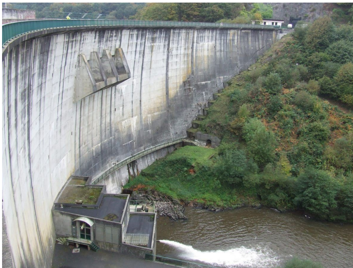
Barrage du Gouët – La Méaugon
