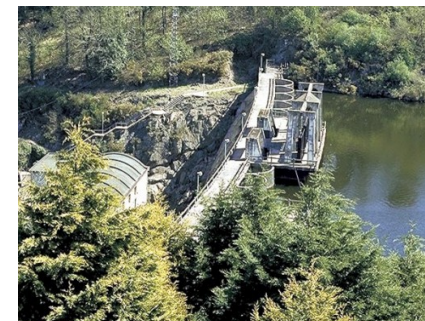
Barrage Pont Rolland – Hillion
