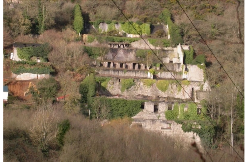
Vue aérienne de la fonderie de Trémuson
