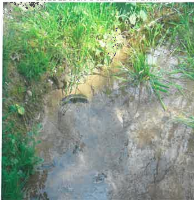
Sortie du cours d'eau busé sur 248M
