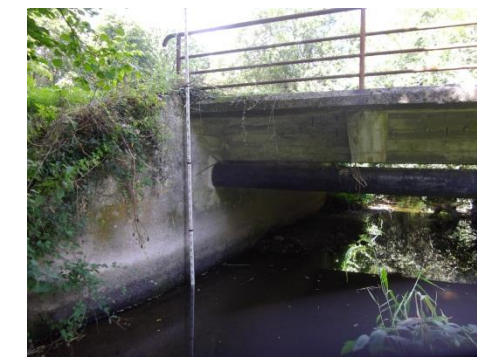
Photo OH vue de l'aval
