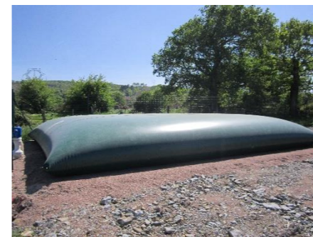
Photographie 5 : Bâche incendie (source : ENCIS Environnement)
