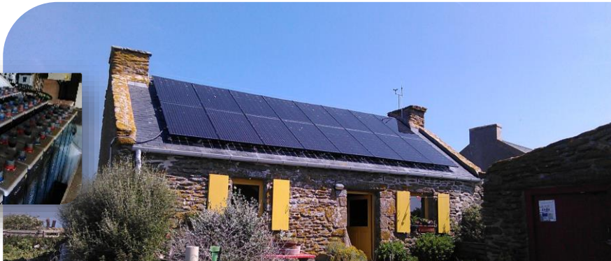
Installation photovoltaïque en autoconsommation 8kWc x2 + stockage batterie - île de Quémènes(29)
