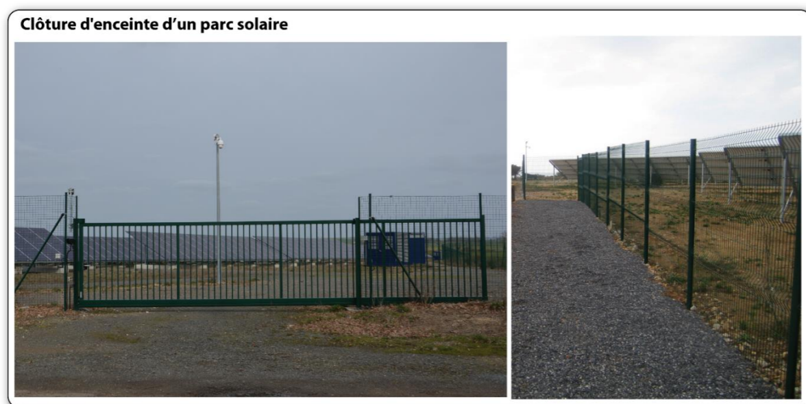
Figure 6 : Clôture de sécurité (source : ENCIS Environnement)
