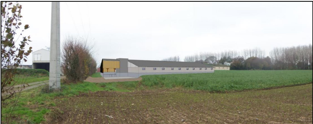
Vue sud du bâtiment engraissement avec la fumière en projet
