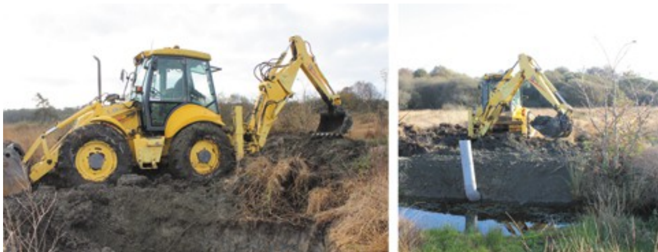
Réparation de l'ouvrage fuyard avec un tracto-pelle – Mise en place du tuyau PVC diamètre 200 mm
