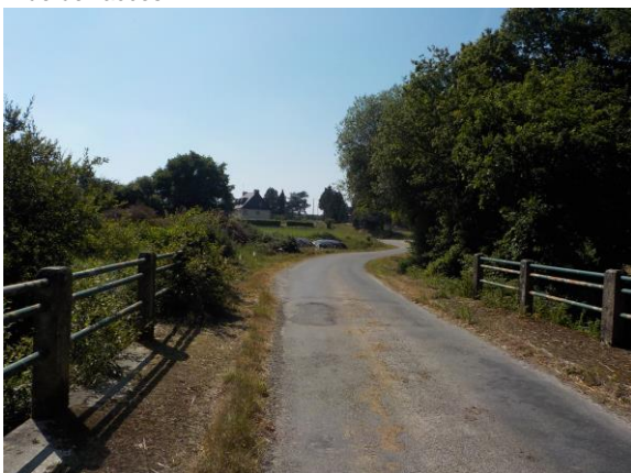
Vue de l'accès
