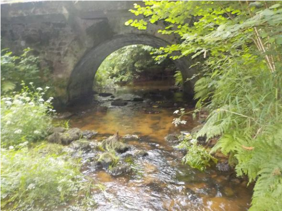
Vue de l'amont
