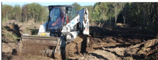
Broyage- Dessouchage à la pelle mécanique – Broyage des petites souches avec un broyeur forestier
