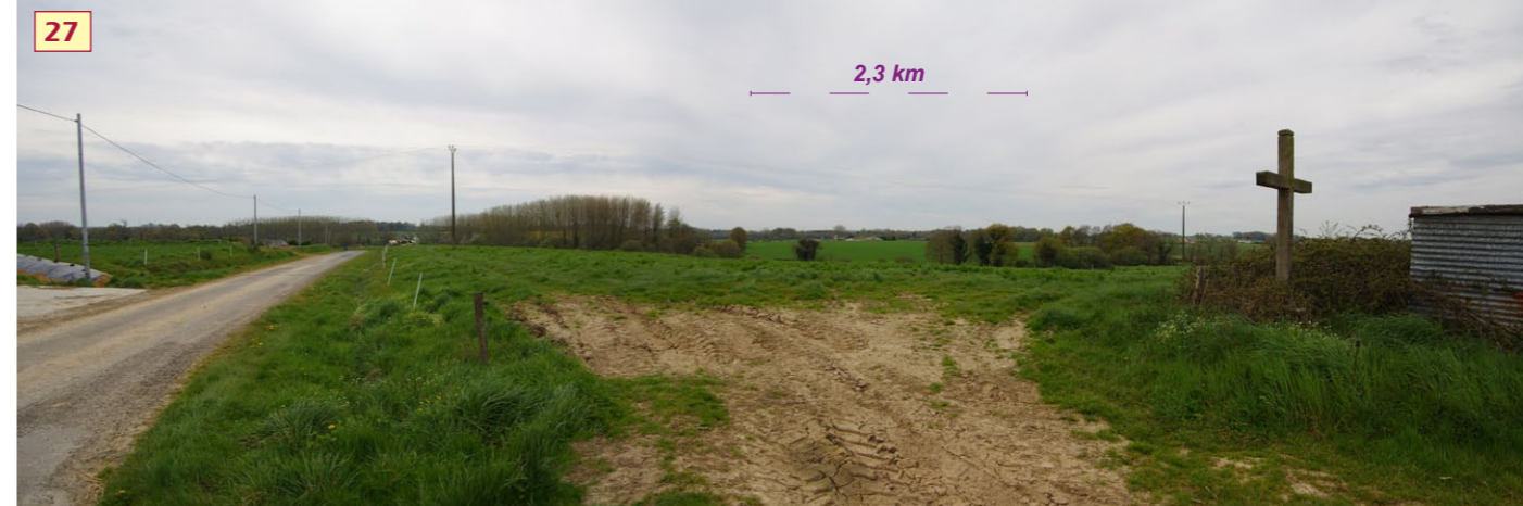
La Biliais : ouverture vers le plateau au sud-ouest. Les peupleraies implantées dans le vallon au premier plan et les haies bocagères apportent une ambiance davantage boisée et des perceptions à plus petite échelle que dans la plupart des autres secteurs situés en ligne de crête.
