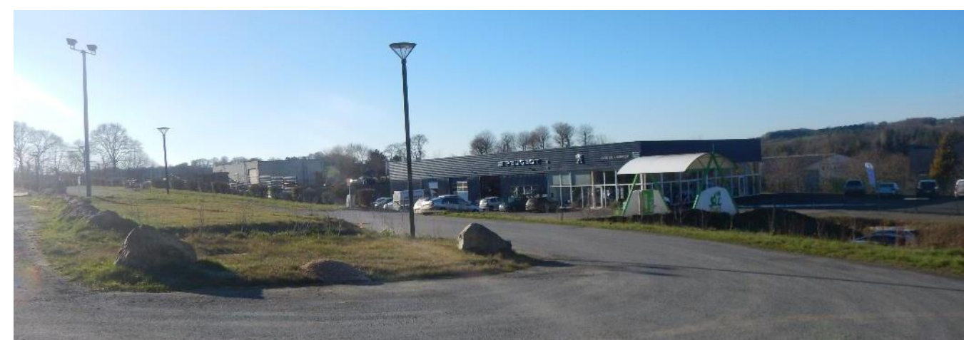
Photo 25 : photos de la ZAC du Courjou en construction et, lots à construire
