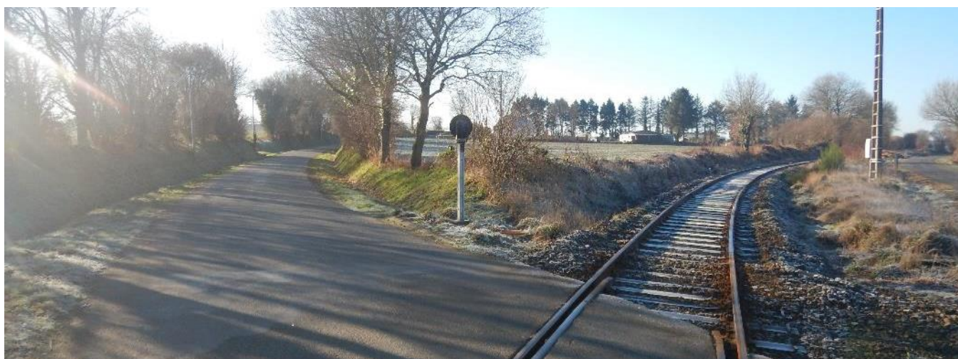
Photo 19 : Voie ferrée Guingamp/Carhaix-Plouguer au croisement avec la route RD20 au sud-ouest du site d'étude
