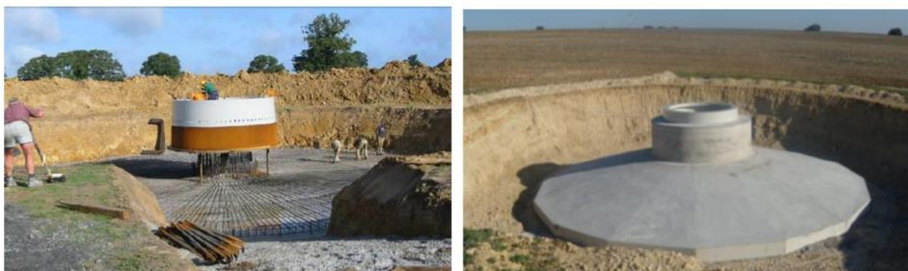
Ferrailage et coulage d'une fondation
