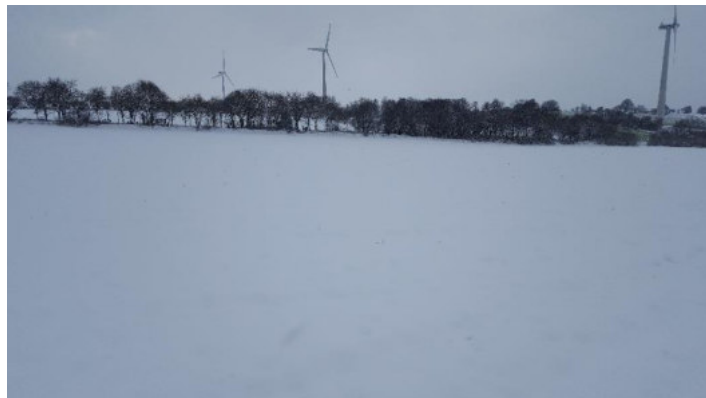
Parcelle d'implantation de l'éolienne E2
