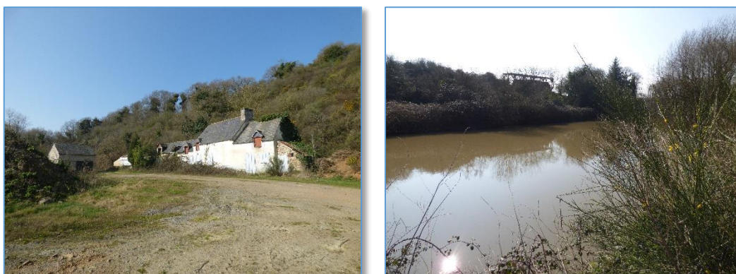
Fig. 36 : Vue n°5a et 5b : Bâtiments désaffectés et plan d'eau à l'Ouest du site
