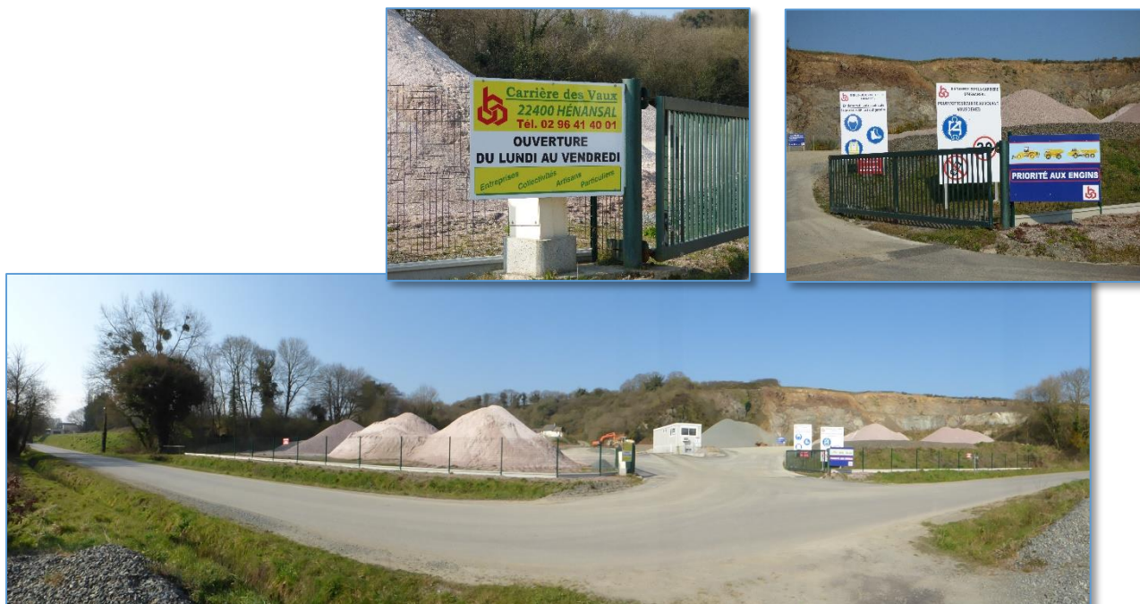
Fig. 32 : Vue n°1 : Accès au site et signalisation
