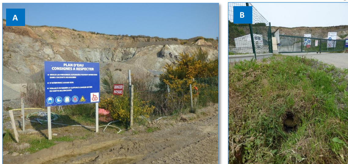
Fig. 7 : Vues A sur le bassin de collecte et de décantation des eaux et vue B sur le point de rejet des eaux au fossé
