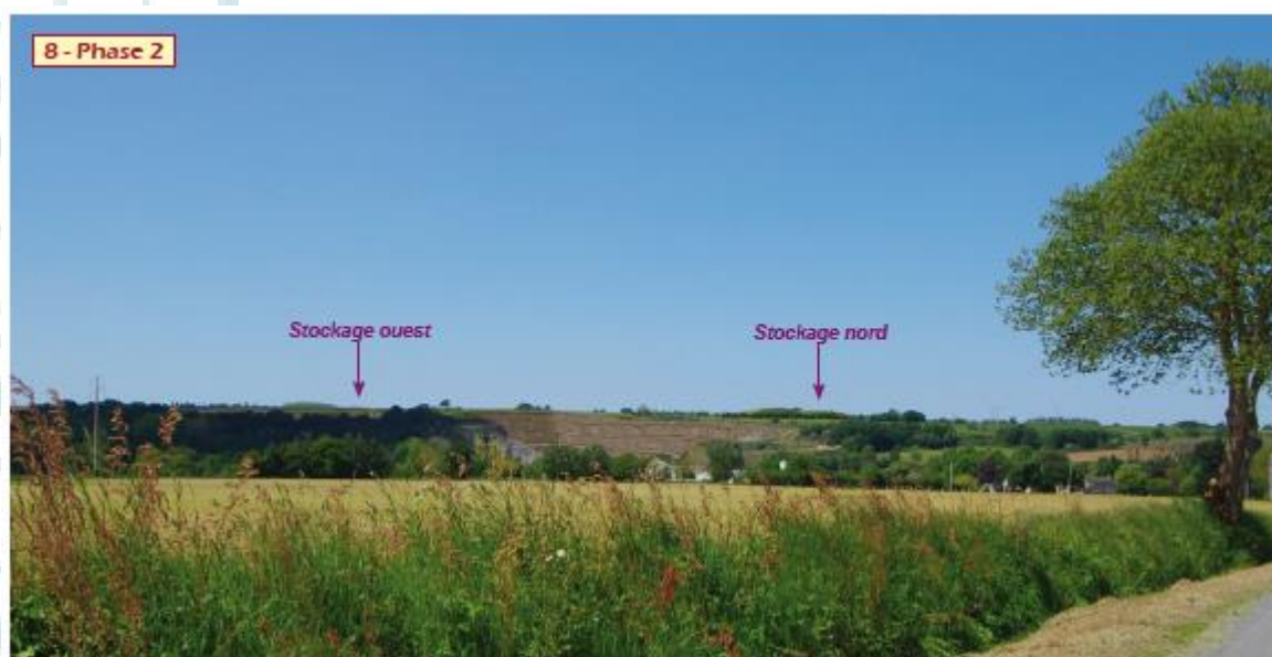
Fig. 28 : Vue sur le site depuis le Sud
