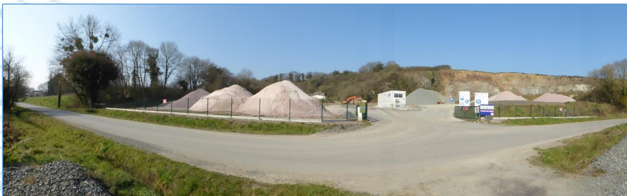
Fig. 12 : Vue n°1 : Accès au site et signalisation
