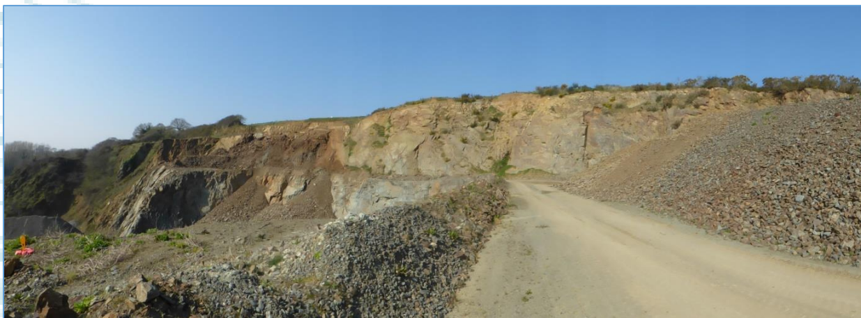
Fig. 15 : Vue n°4 : Fronts supérieurs
