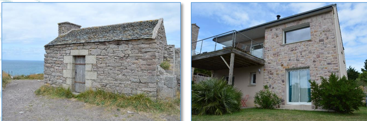
Fig. 15 : Vue sur le bâti en grès d'Erquy à gauche bâti ancien : corps de garde, à droite, bâti récent : hameau de Tu Es Roc
