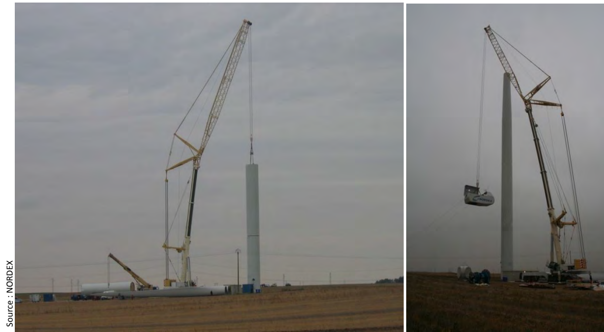
Figure 100 : Montage du mât et de la nacelle
