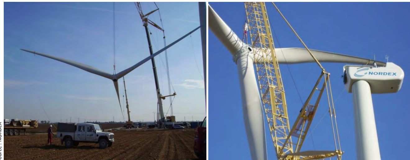
Figure 101 : Montage des pâles
