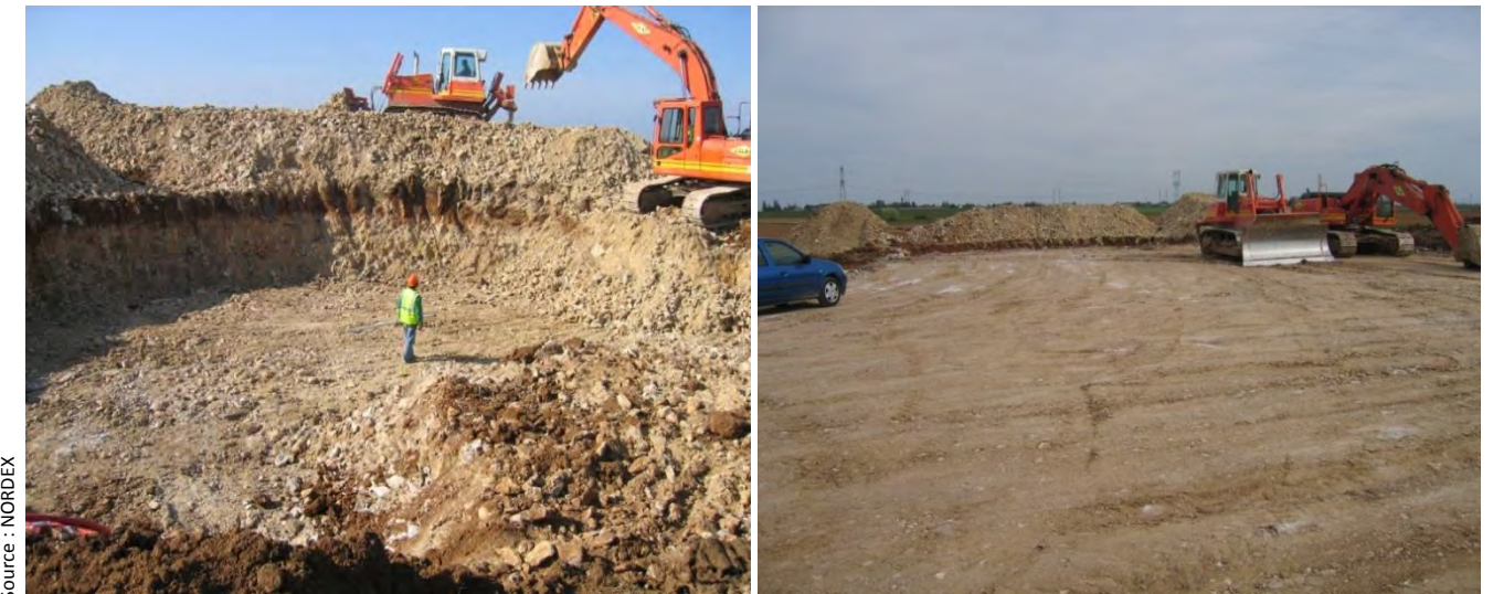
Figure 95 : Travaux pour la réalisation de chemins d'accès et de creusement des fondations
