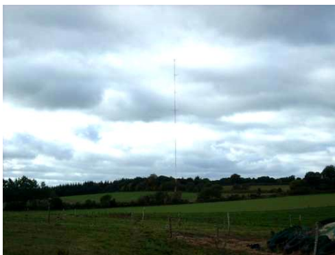
Figure 4 : Photographie du mât installé sur site
