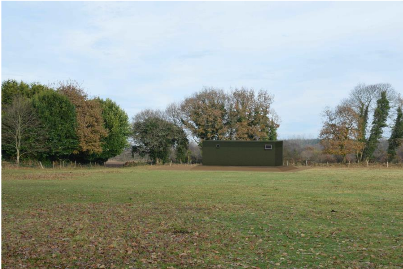
Figure 4 : Postes de livraison au nord-est de l'éolienne E4 (source : RWE, 2020)
