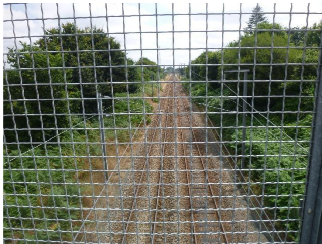
Photographie 29 : Voie ferrée située au nord du bourg de Louargat (Source : ENCIS Environnement)
