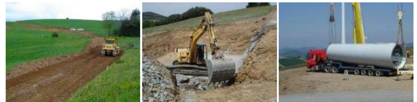
Photographie 119 : Illustration d'un chantier éolien
