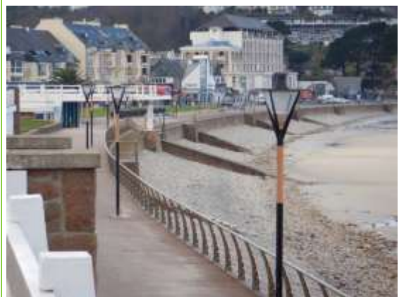
Fig. 50. Mur de la plage de Trestraou
