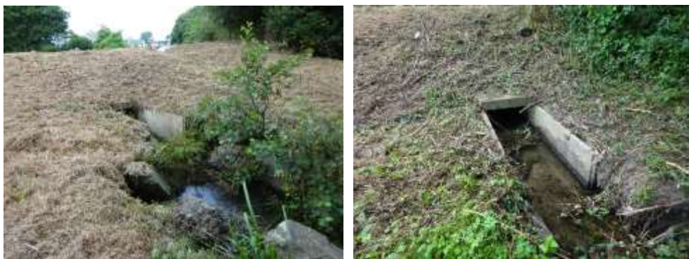
Fig. 30. Ouvrages de régulation à Kerbilhoat sur le bassin versant du Gruguil (Pegaze 1 à gauche, Pegaze 2 à droite)
