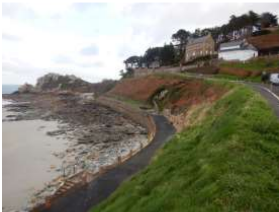
Fig. 47. Mur de la plage de Trestrignel
