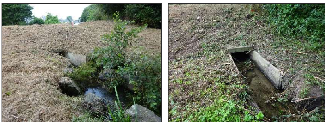
Fig. 59. Ouvrages de régulation sur le Gruguil (Pégaze 1 et 2)
