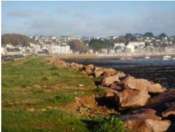
Fig. 41. Enrochements de l'esplanade de la Douane – Pont-Gouennec
