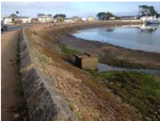
Fig. 43. Route formant digue entre bassin du Linkin et le port
