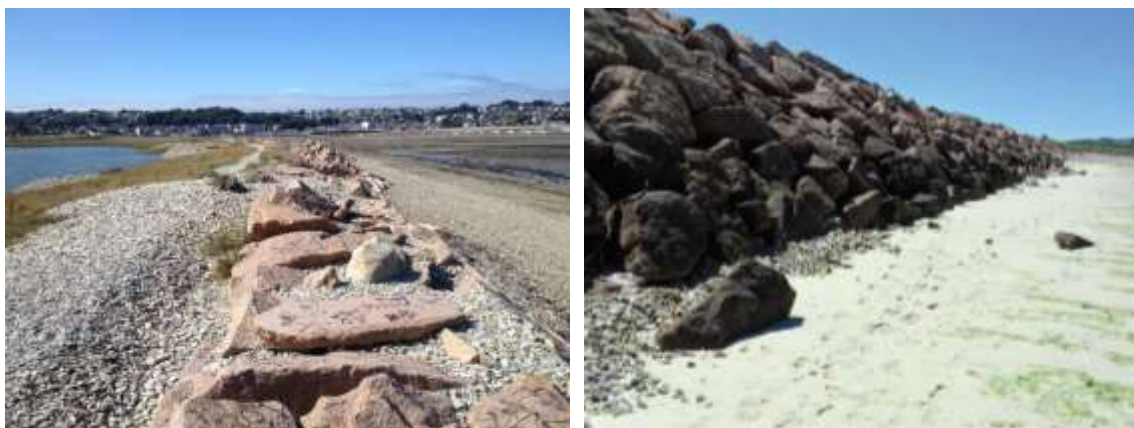
Fig. 35. Digue du Lenn
