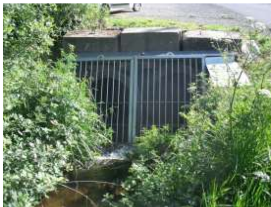
Fig. 61. Grilles inclinées pour limiter l'obstruction des buses
