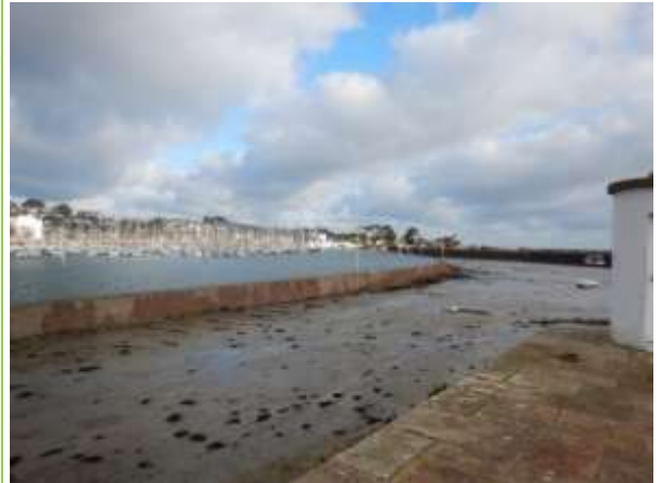
Fig. 42. Mur du bassin à flot – Port de Perros-Guirec
