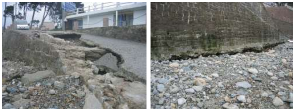
Fig. 78. Dégâts sur la plage de Trestraou dus à la tempête du 10 mars 2008
