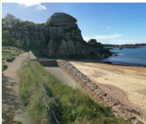
Fig. 55. Mur de la plage de la Bastille
