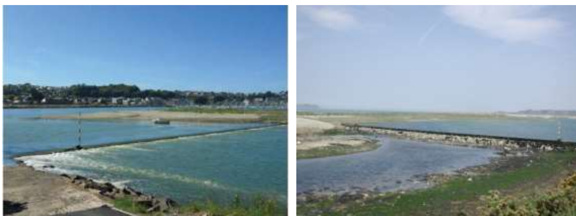
Fig. 36. Seuil d'entrée du bassin du Lenn
