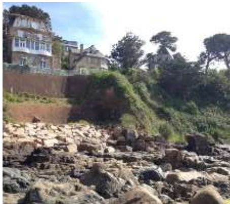
Fig. 49. Mur sous la parcelle cadastrale AP51 à Pors Nevez
