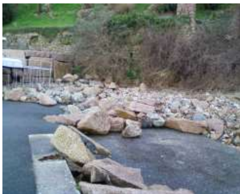
Fig. 82. Blocs de granit déplacés par les vagues et centre nautique à Trestraou (2 février 2014)
