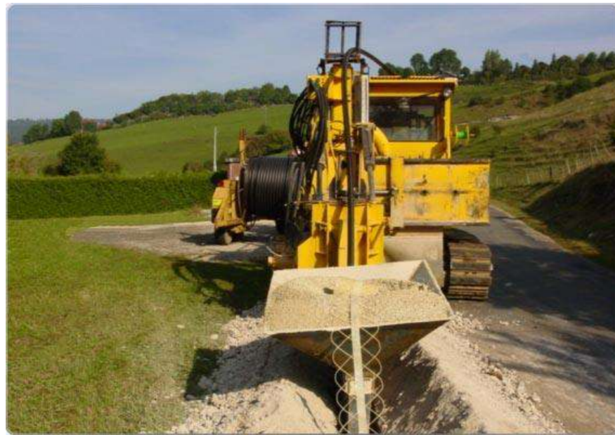
Photo 121 : la pose d'un câble souterrain depuis le poste de livraison jusqu'au réseau électrique public
