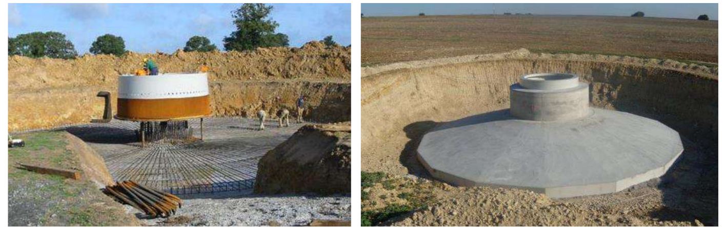
Photo 117 : Le ferrailage et le coulage d'une fondation d'éolienne
