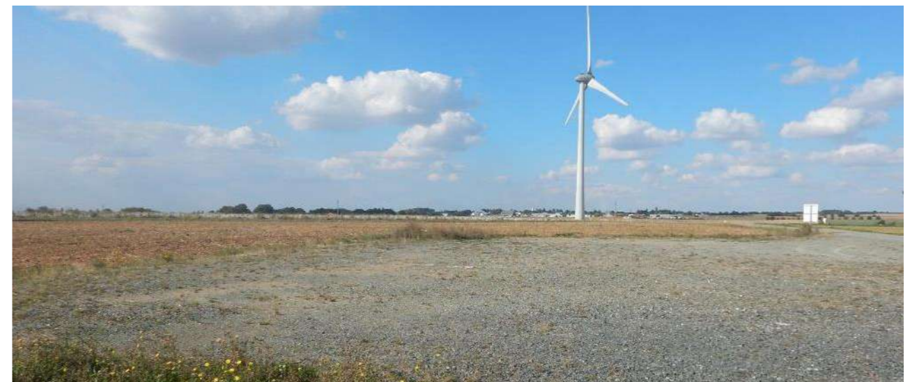
Photo 118 : Exemple d'aire de grutage depuis le pied d'une éolienne
