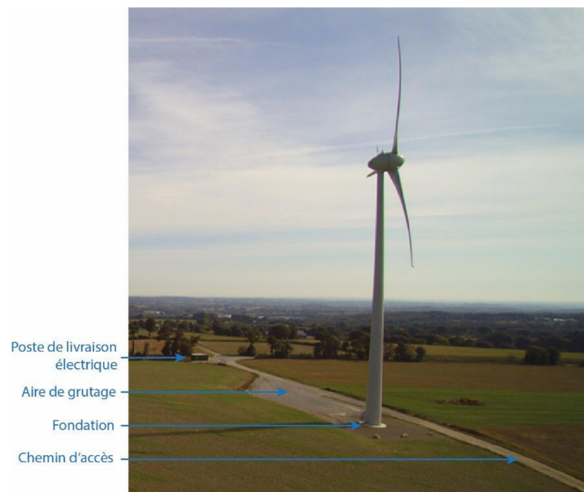
Figure 3 : une éolienne et ses aménagements annexes (AEPE Gingko)
