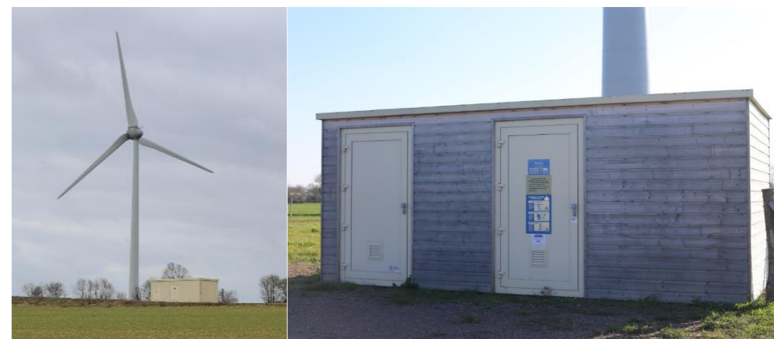
Figure 5 : exemples de poste de livraison électrique
