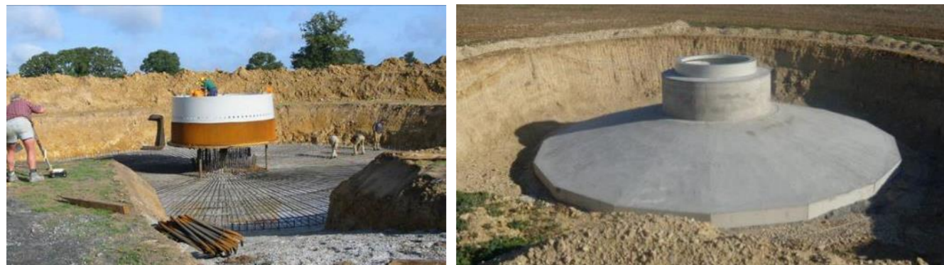
Figure 3 : le ferrailage et le coulage d'une fondation d'éolienne
