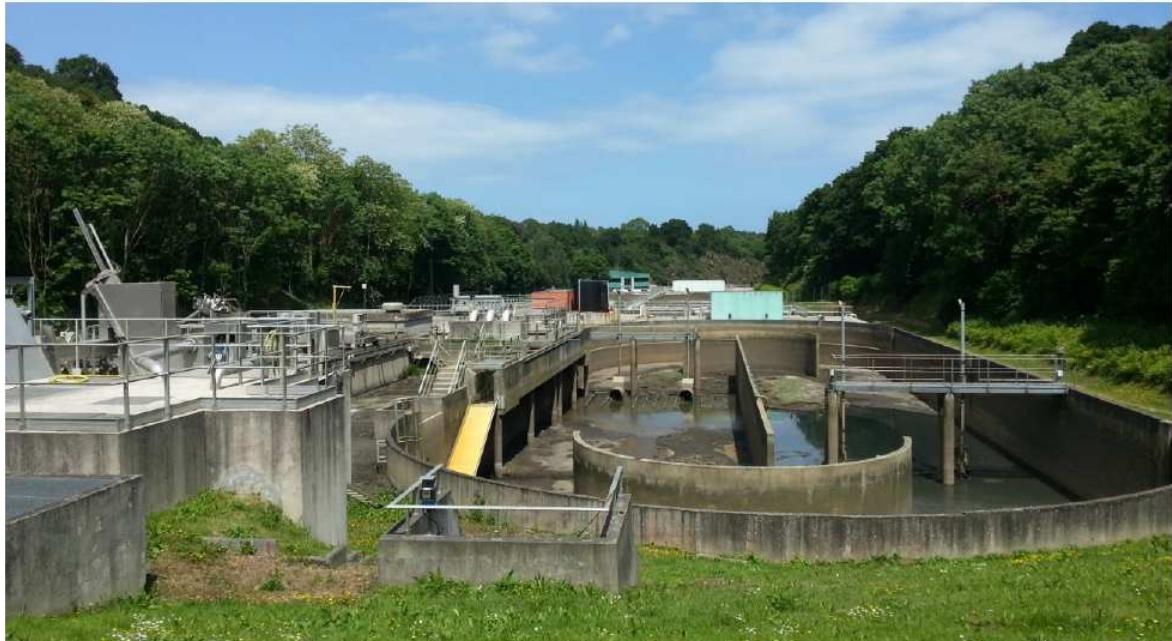
Vue d'ensemble de la station du Légué depuis arrivées des eaux brutes, au premier plan le bassin tampon
