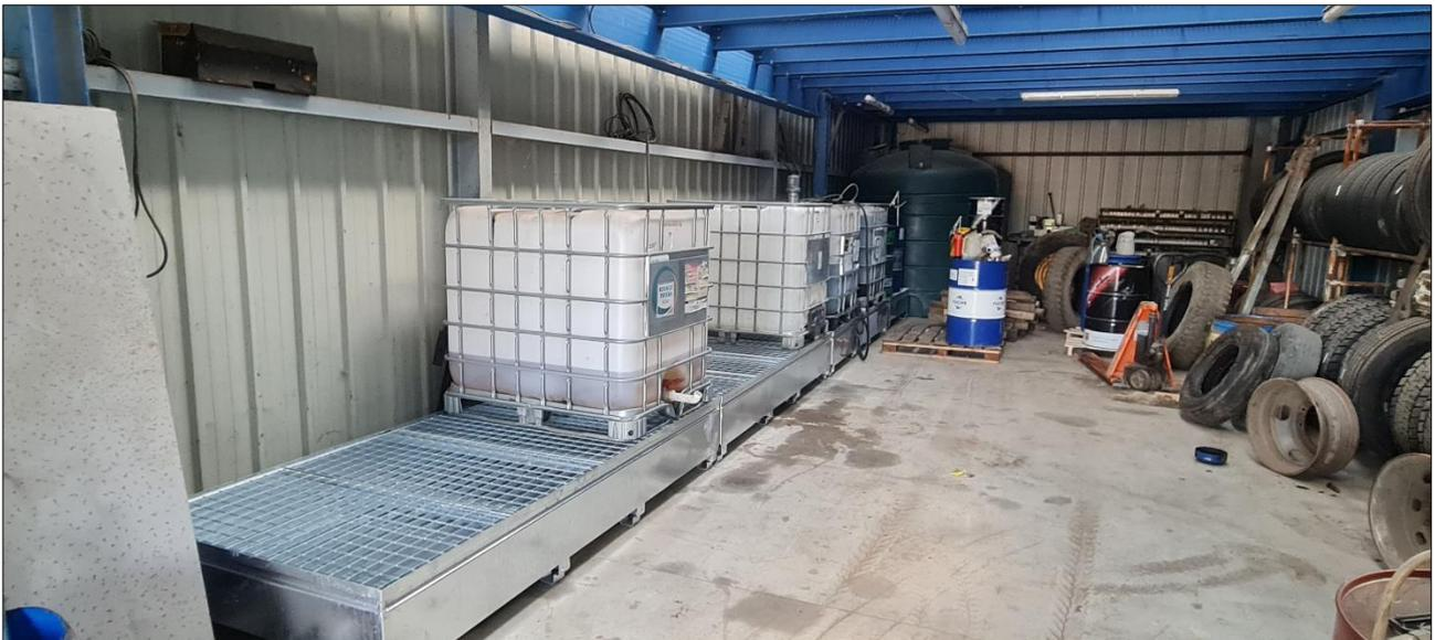
Illustration 7 : Mise en place des rétentions dans l'atelier de mécanique
