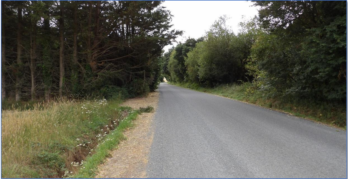
Fig. 49 : Vue E : RD65, en provenance de l'Est
