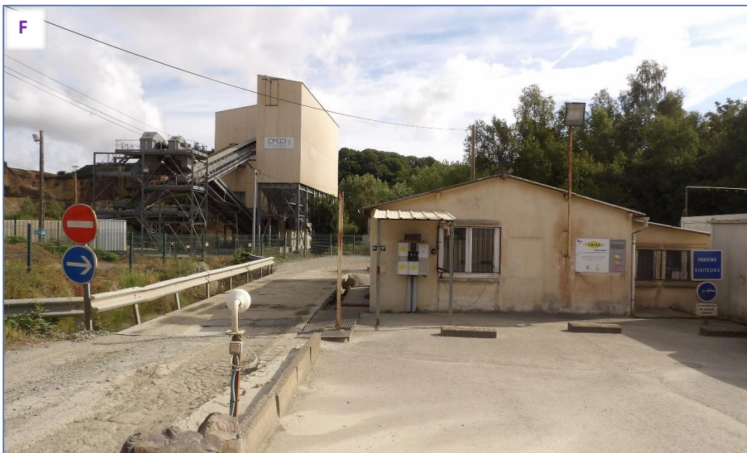
Fig. 19 : Vue sur les bureaux actuels qui seront prochainement démantelés (hors périmètre du projet)
