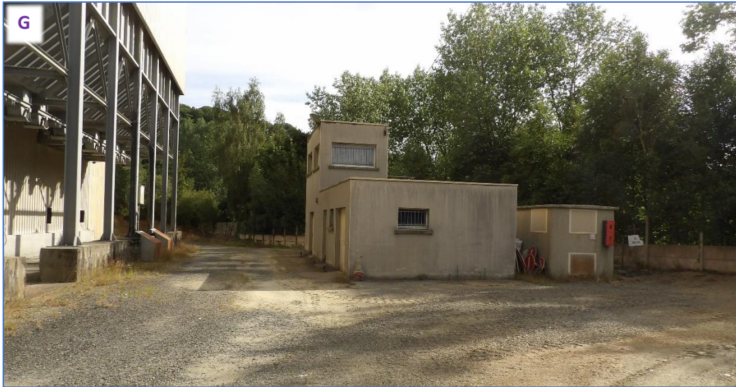
Fig. 20 : Vue sur le poste de pilotage des installations qui sera converti en futurs bureaux
