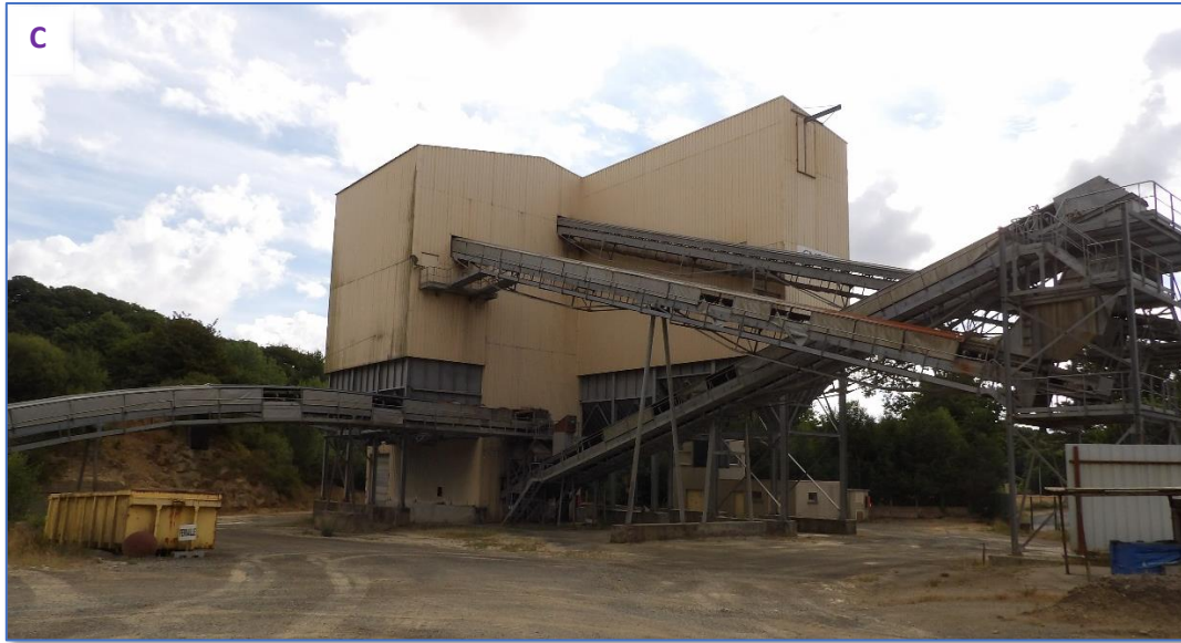
Fig. 16 : Installation primaire qui sera démantelée pour réutilisation sur un autre site
