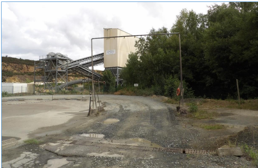
Fig. 63 : Portique d'aspersion des bennes de camions (qui sera déplacé)
