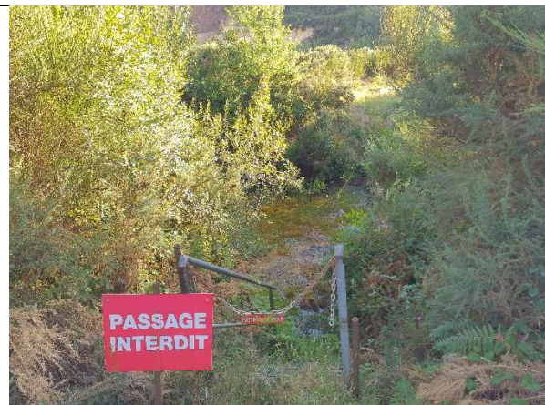
Figure 13. Bassin de décantation (photo : M. ROMET)
