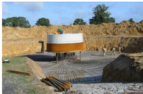
Photo 8 : Le ferrailage et le coulage d'une fondation d'éolienne
