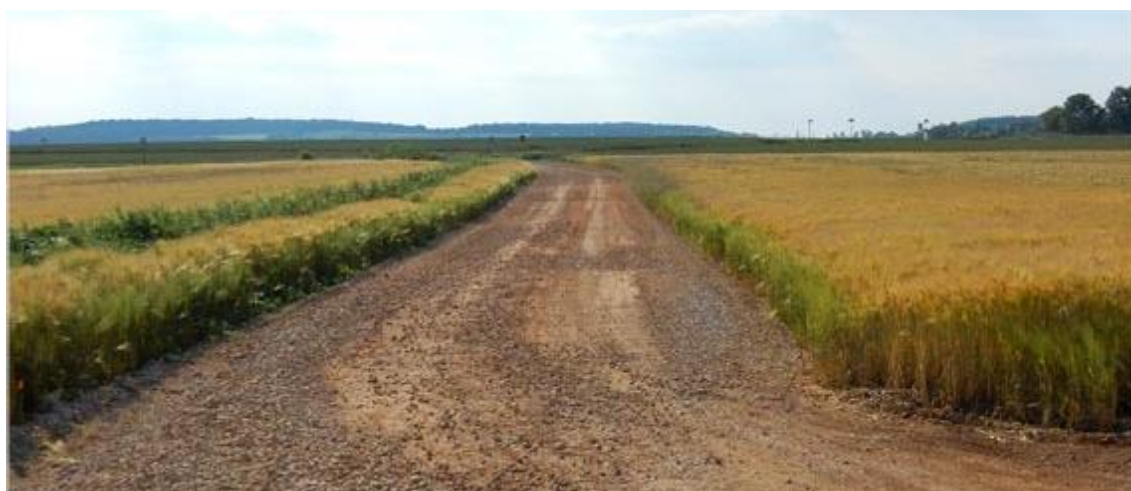
Photo 4 : un exemple de voie d'accès à un parc éolien en milieu agricole
