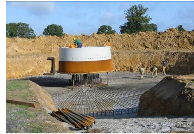
Photo 2 : Le ferrailage et le coulage d'une fondation d'éolienne
