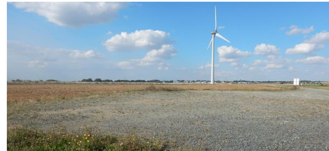
Photo 3 : un exemple d'aire de grutage depuis le pied d'une éolienne
