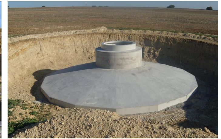
Photo 2 : Le ferrailage et le coulage d'une fondation d'éolienne
