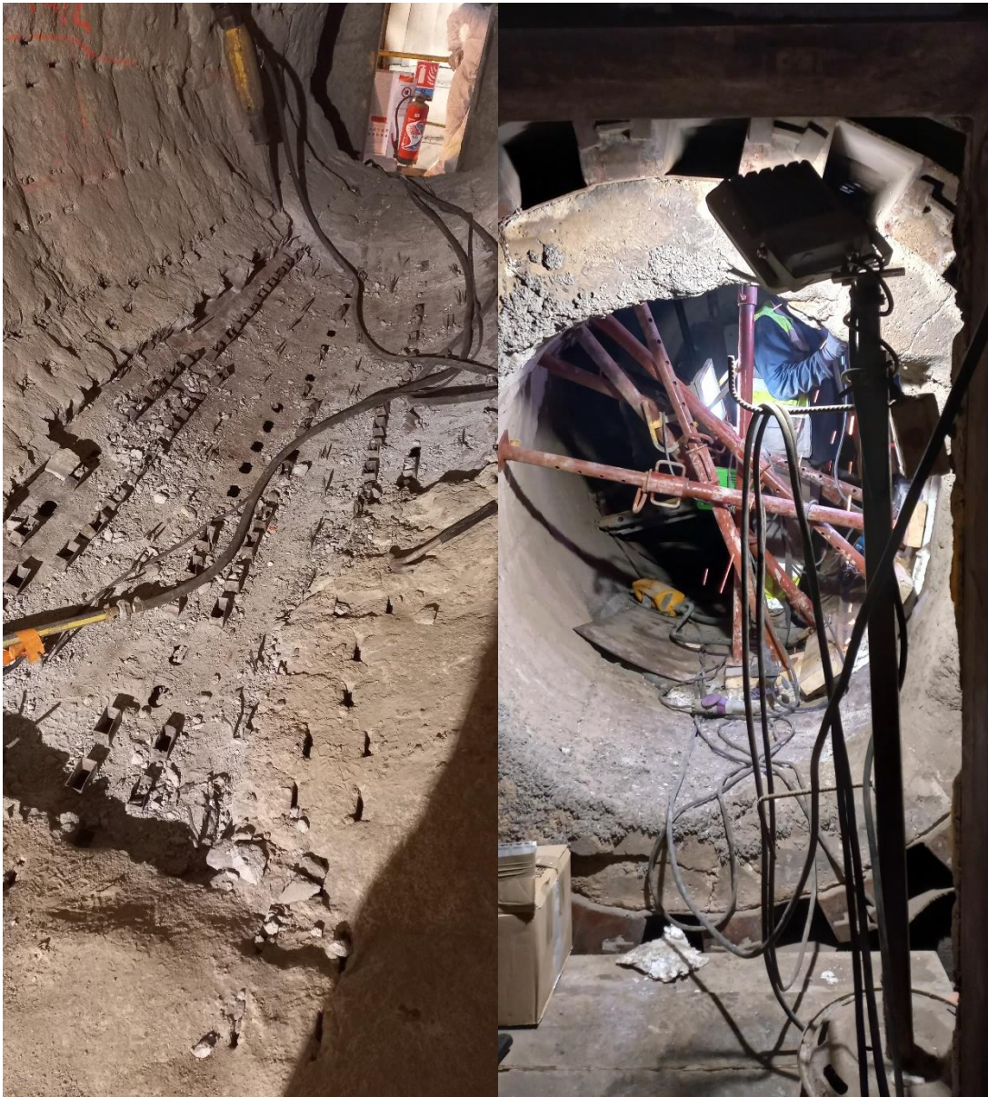
Réfection de la zone buse du four
