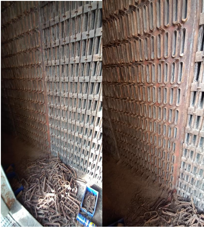
Remplacement d'un caisson de tubes refroidisseur
