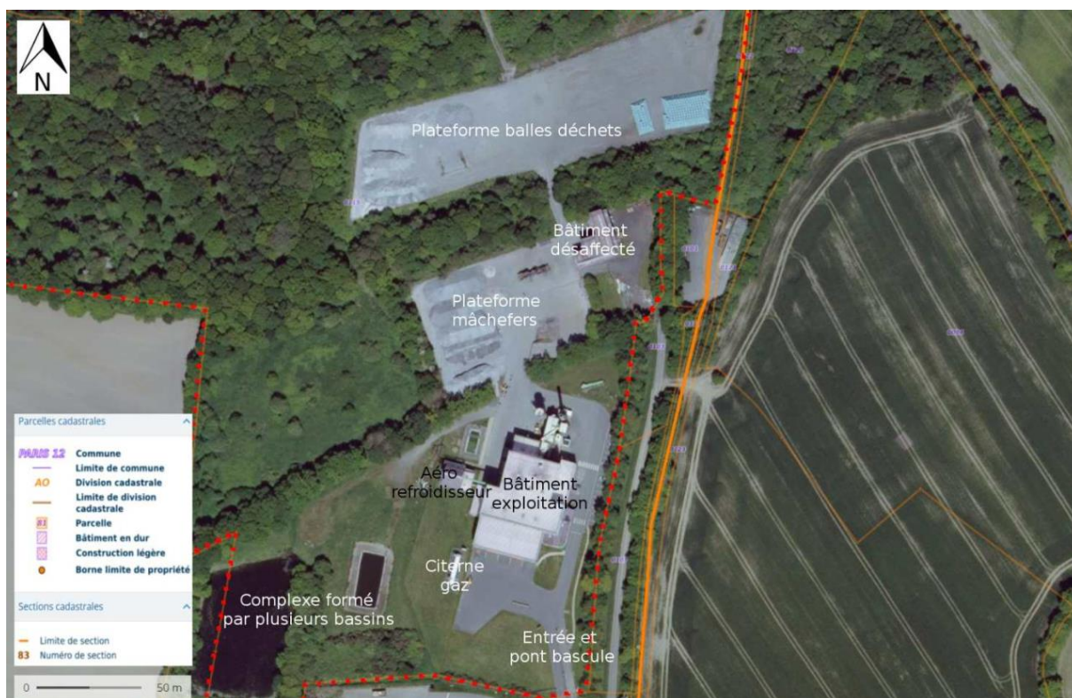
Figure 3 : Photographie aérienne localisant les installations de l'UVE
