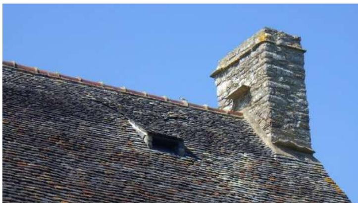
Figure 17. Exemple de chiroptière aménagée sur la toiture d'un grenier pour l'accès à un caisson (photo prise hors site © Biotope)
