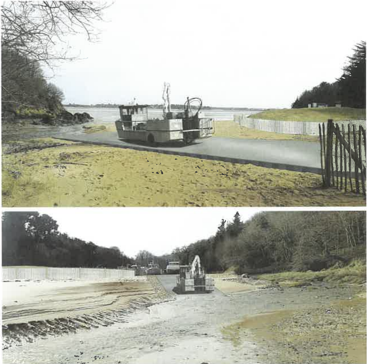
Figure 7 : Photomontages de la cale, des ganivelles et du géotextile (source : setur, 2019)
