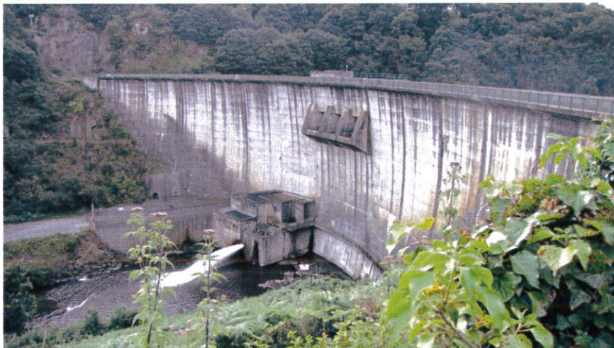
Vue aval du barrage de Saint-Barthélémy (source : Etude de dangers d'Artelia)
