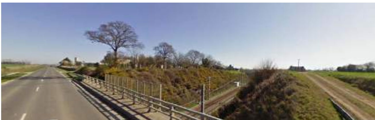
Photo 46 : La vue vers le périmètre d'étude immédiat depuis la RD793. Dans l'axe de la route, les bâtiments de la Coopérative de Broons et, en contrebas, la vision sur la voie ferrée encaissée (ligne ferroviaire Rennes/Saint-Brieuc/Brest)
