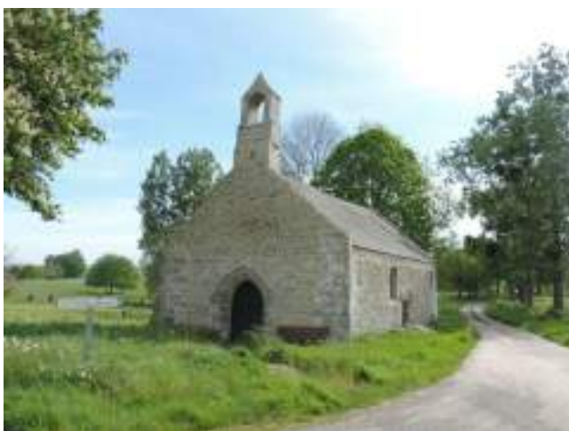
Photo 82 : La chapelle de Leslians, dite aussi des Noës. Le périmètre d'étude immédiat s'inscrit à 700 m en arrière du bâtiment
