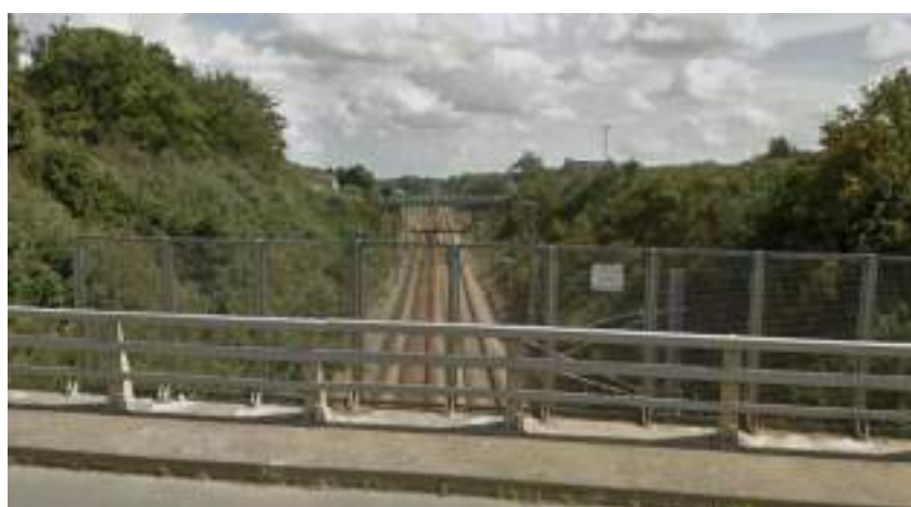
Photo 11 : La ligne ferroviaire Rennes/Saint-Brieuc/Brest vue depuis la RD793
