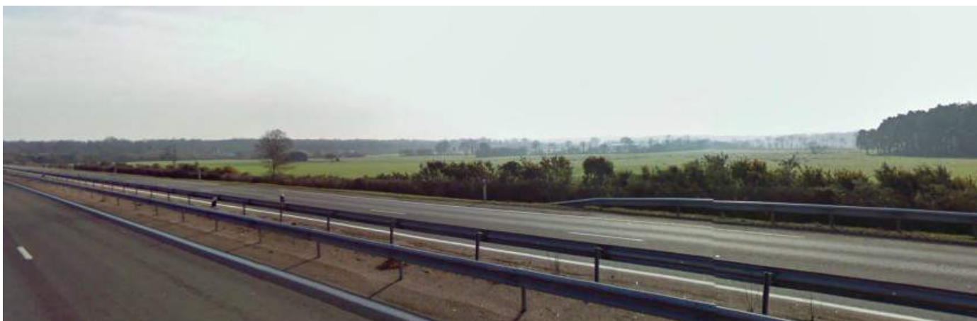
Photo 31 : La vue ouverte depuis la RN176 vers le site éolien en projet
