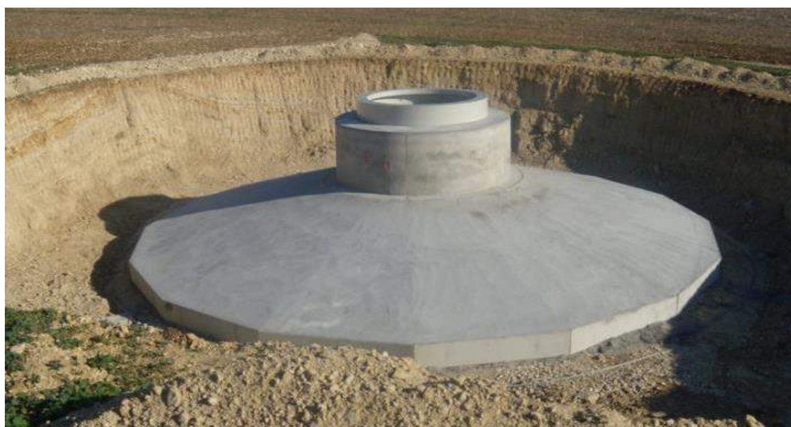
Photo 1 : Le ferrailage et le coulage d'une fondation
