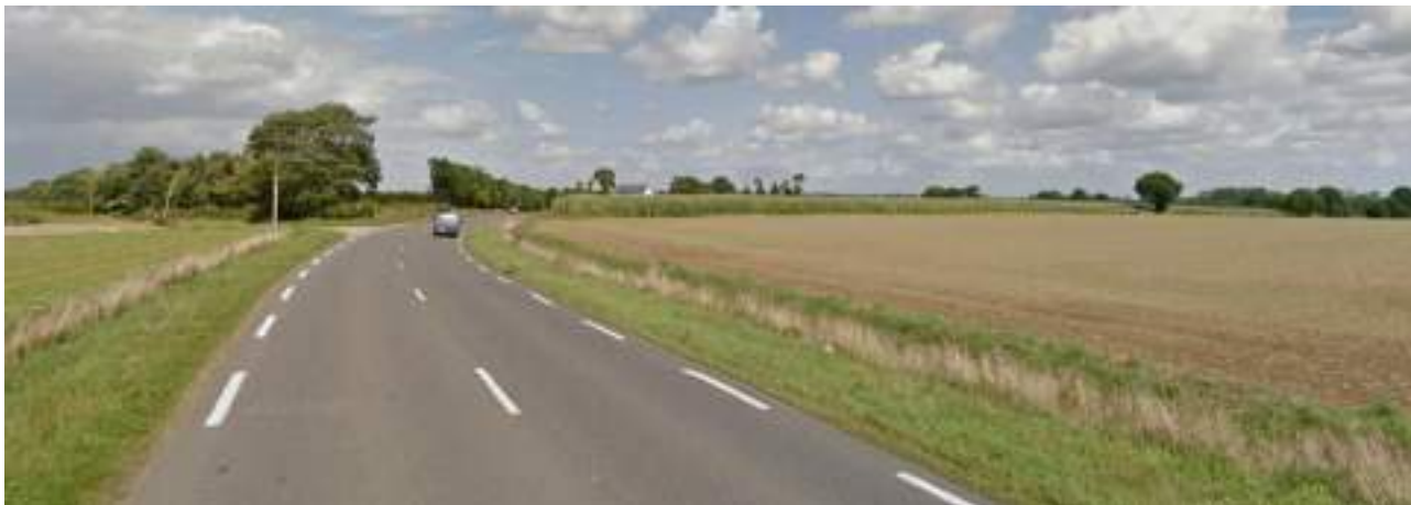
Photo 10 : La RD793 entre Broons et la ligne ferroviaire Rennes/Saint-Brieuc/Brest
