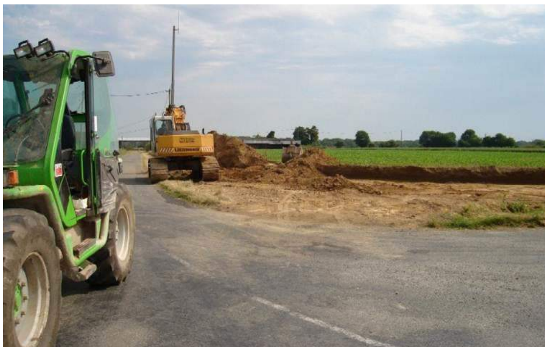
Photo 88 : Les travaux de rectification d'un virage
