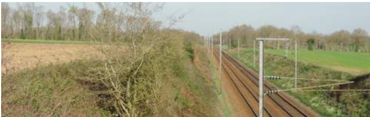
Photo 48 : La voie ferrée à la hauteur du périmètre d'étude rapproché. Le parc éolien s'inscrira de part et d'autre de la voie
