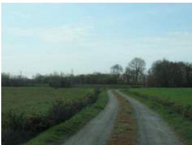
Photo 63 : L'insertion de la voie ferrée
