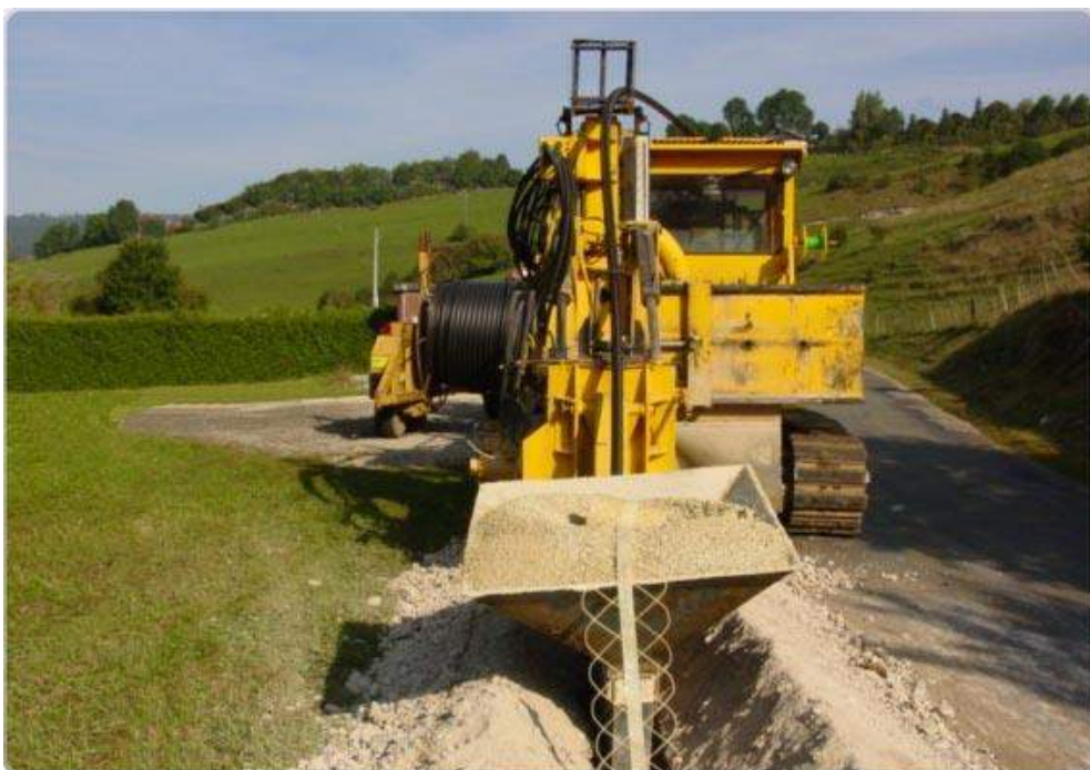
Photo 4 : La pose d'un câble souterrain depuis le poste de livraison jusqu'au réseau électrique national
