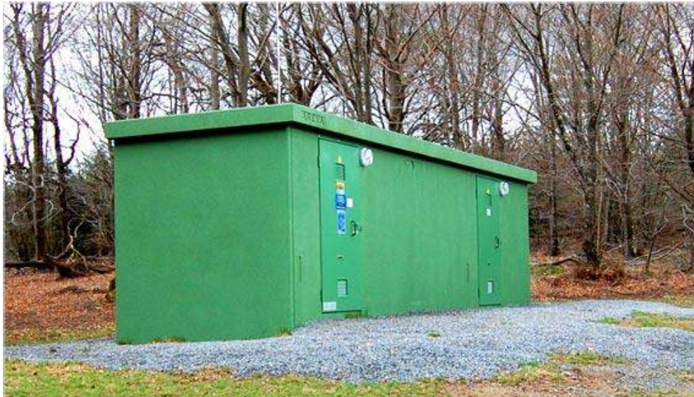
Photo 5 : Un exemple de poste de livraison électrique
