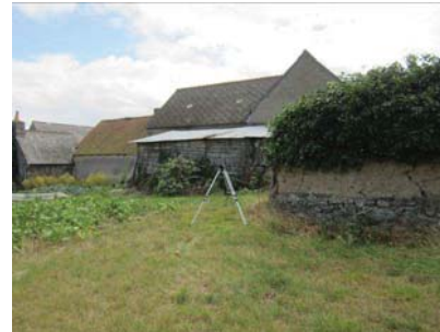
Vue en direction de l'habitation
