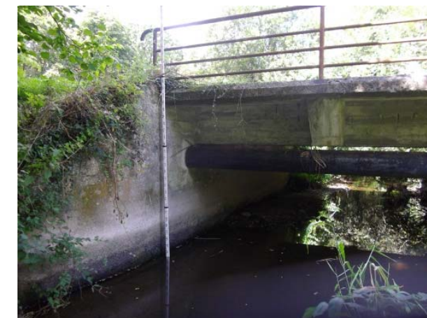
Photographie 3 : OH de franchissement du Petit Doré au sud de la RN164 vue de l'aval
