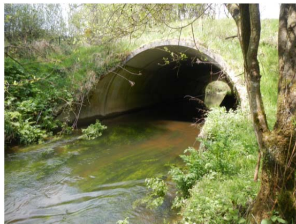
Photographie 1 : OH10 vue de l'aval
