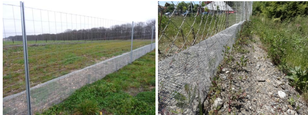
Photographie 24 : Exemple de clôtures à mailles fines 6 mm x 6 mm (© Egis)
