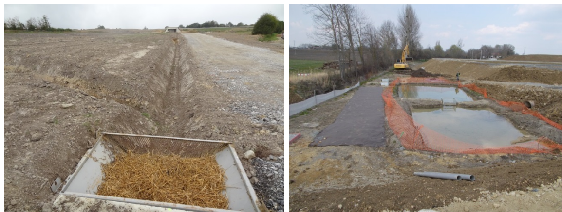
Photographie 18 : Exemples de dispositifs d'assainissement provisoire mis en place en phase travaux (© Egis / D. Ferreira)
