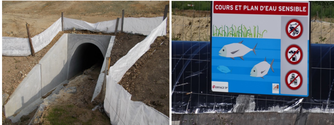
Photographie 21 : Principe d'implantation de clôtures géotextile pour protéger le cours d'eau du Petite Doré et sa ripisylve et panneau de sensibilisation (© Egis / D. Ferreira)
