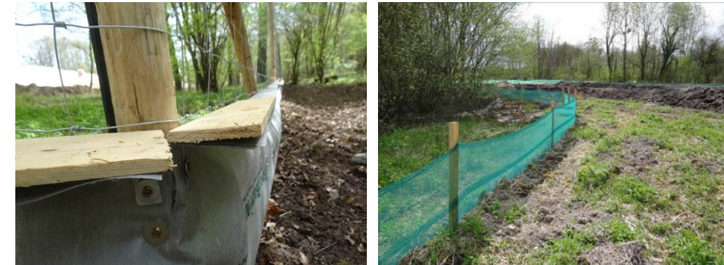
Photographie 23 : Exemple de fixation de bavolet et barrières anti-intrusion posées (© Egis)
