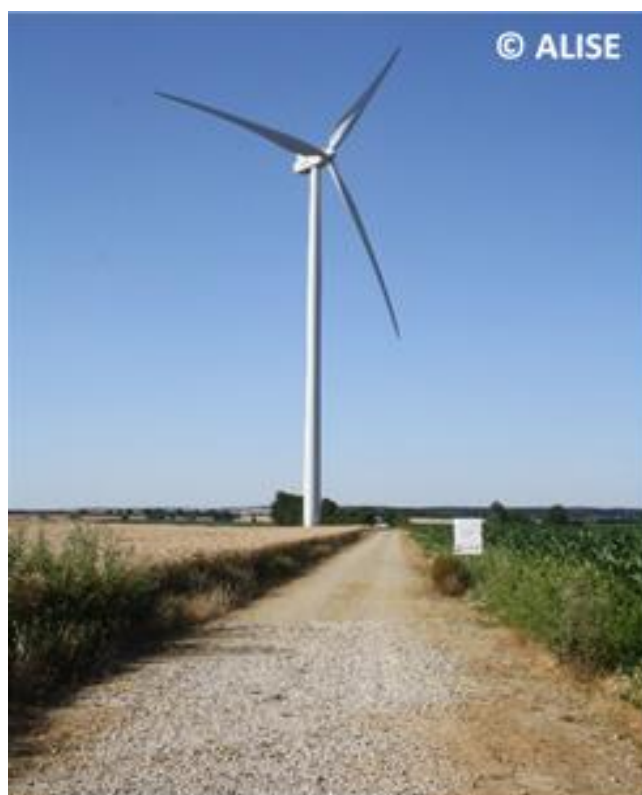
Photo 6 : Exemple de piste d'accès aux éoliennes
