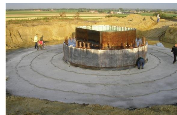
Photo 3 : Durcissement béton
