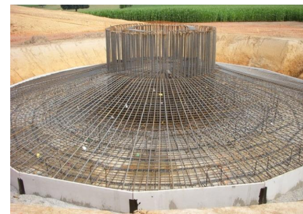
Photo 2 : Excavation et préparation de l'armature
