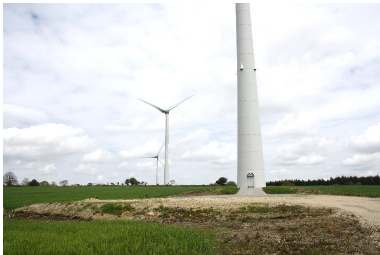
Photo 31 : Surface au sol occupée par l'éolienne et la piste d'accès
