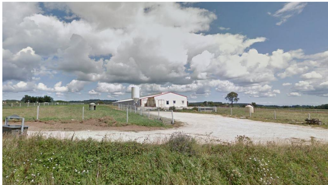
Photo 24 : Elevage de poules pondeuses Saint Jean 437m de E2
