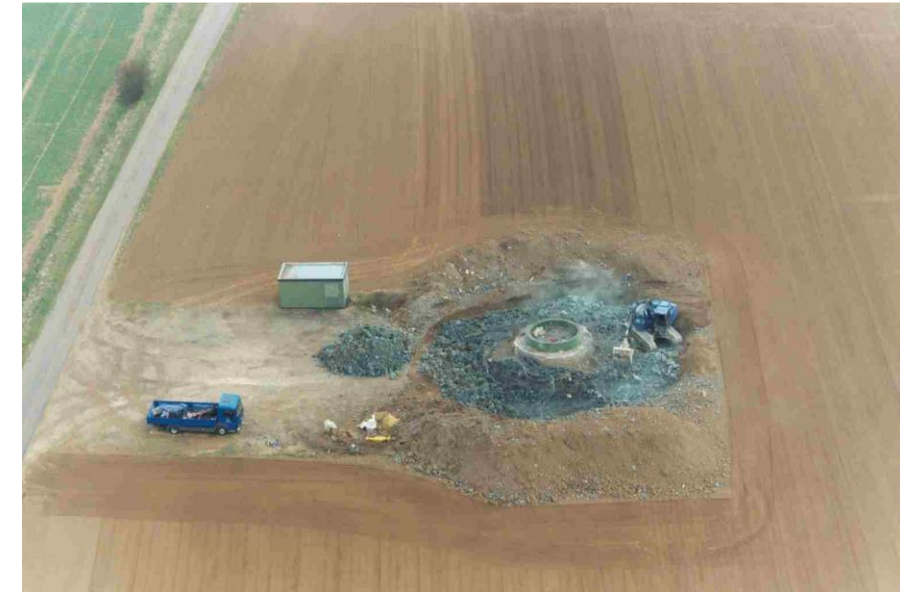
Photo 23 : Exemple de démontage de la plateforme et des fondations d'une éolienne
