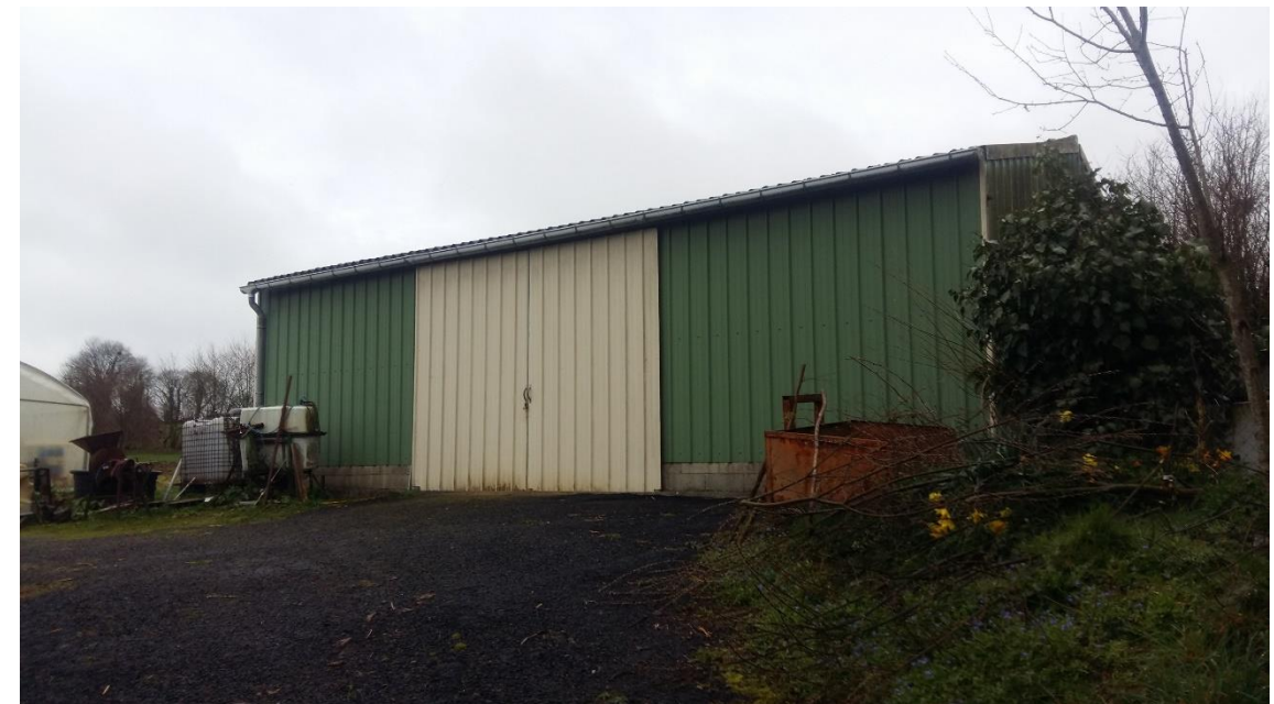
Photo 26 : Hangar de stockage de Guerfestou 459m de E1
