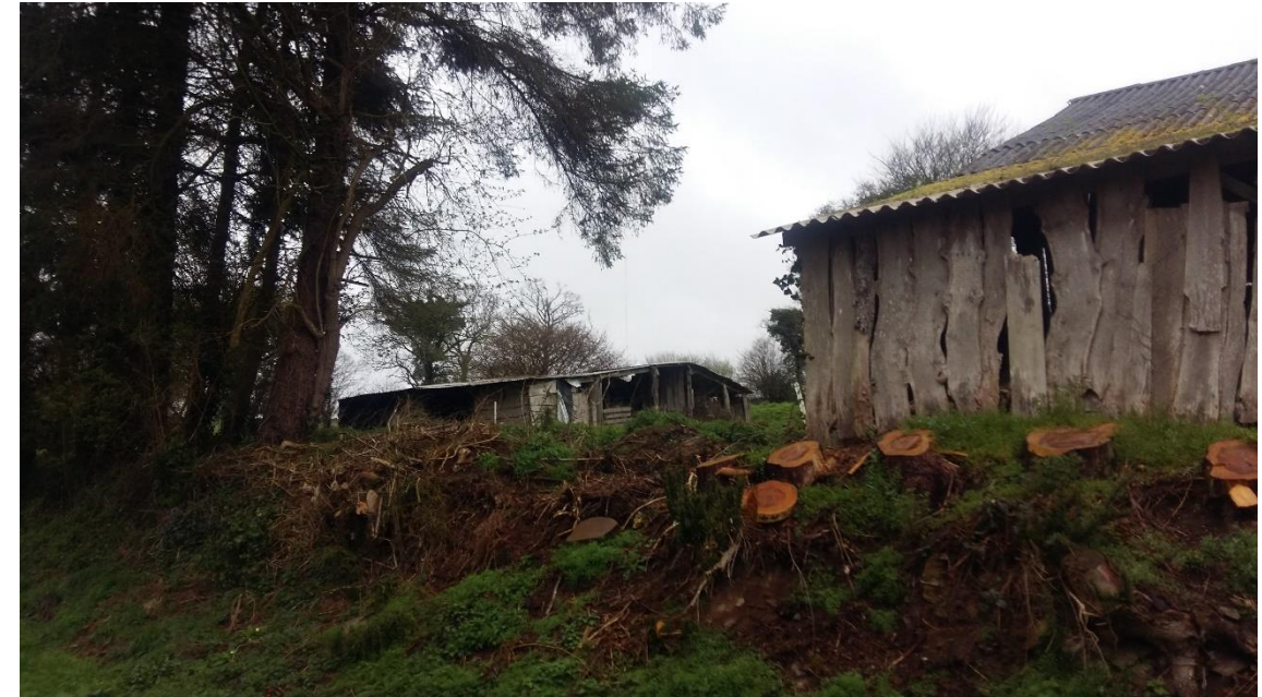
Photo 25 : Hangar à l'abandon à Kermoneur 488m de E2
