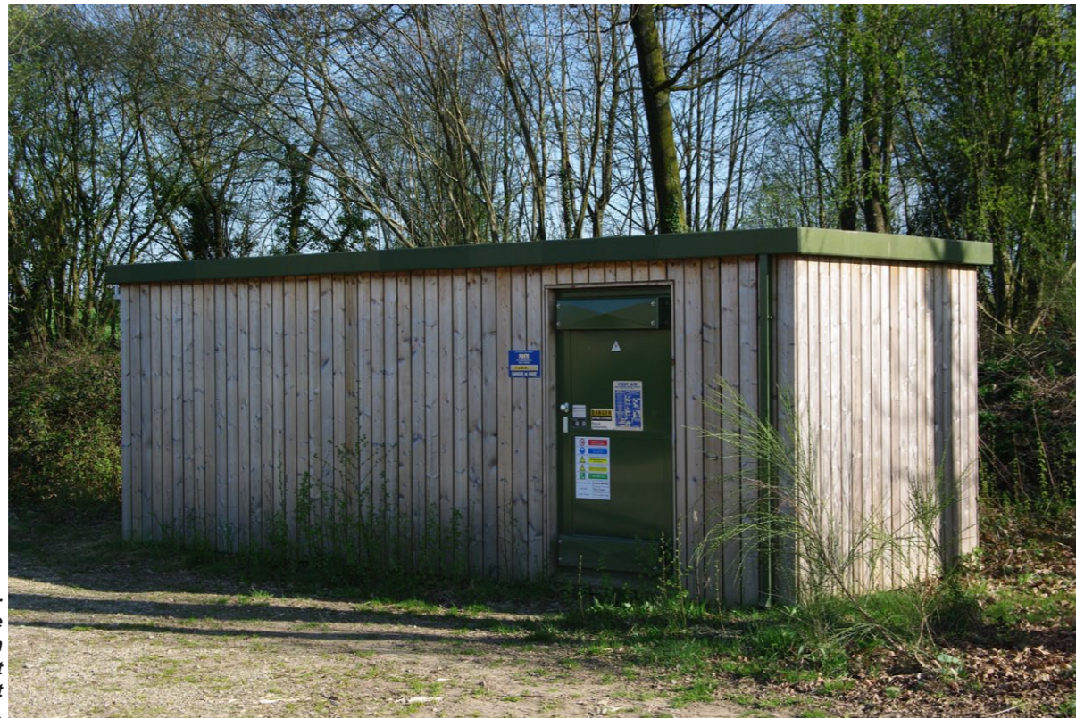
Exemple d'habillage d'un poste de livraison par un bardage en bois et de la teinture vert kaki.
