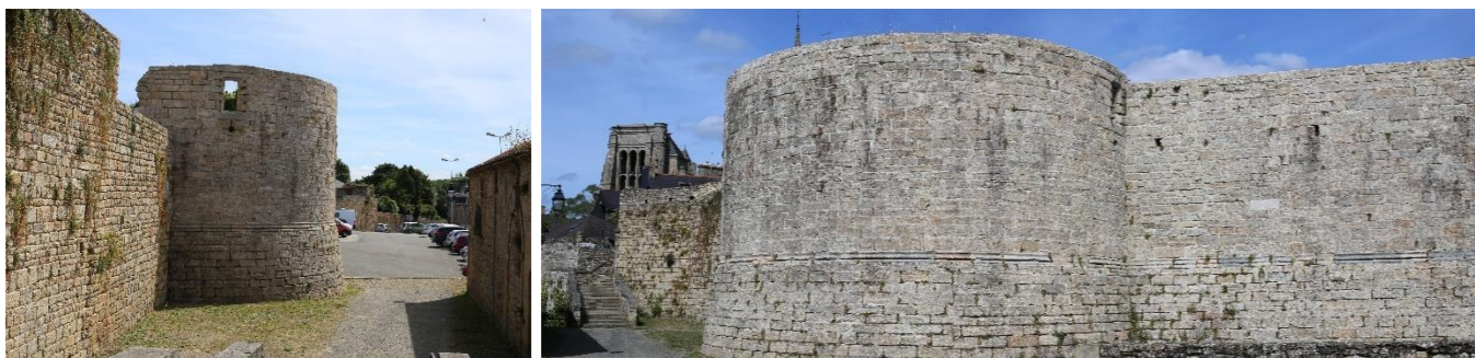
Photo 65 : Les remparts du château de Guingamp
