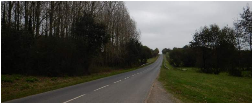
Photo 27 : La RD41 aux abords du périmètre d'étude immédiat
