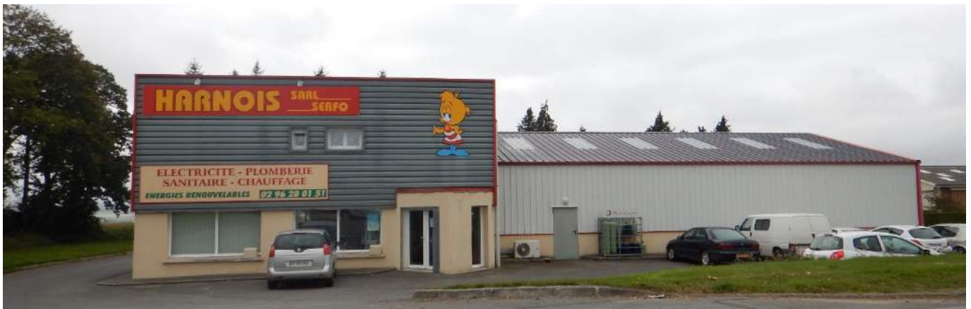
Photo 16 : établissement artisanal au sud du bourg de Trévé
