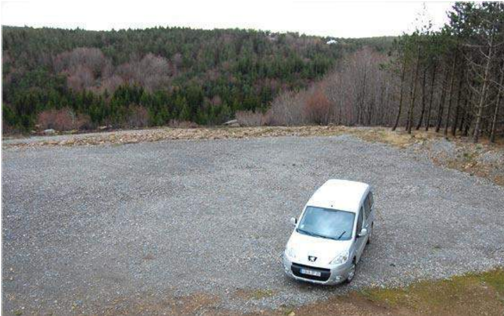
Photo 2 : Un exemple d'aire de grutage empierrée au pied d'une éolienne
