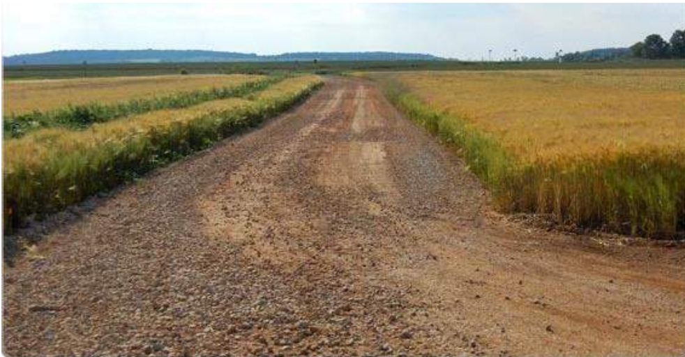
Photo 3 : Un exemple de piste de desserte d'un parc éolien en milieu agricole
