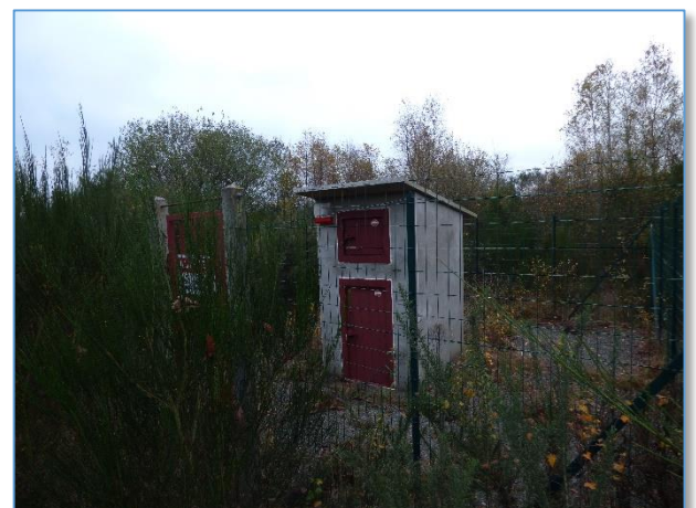
Fig. 28 : Vue n°4 : Ancien local explosifs
