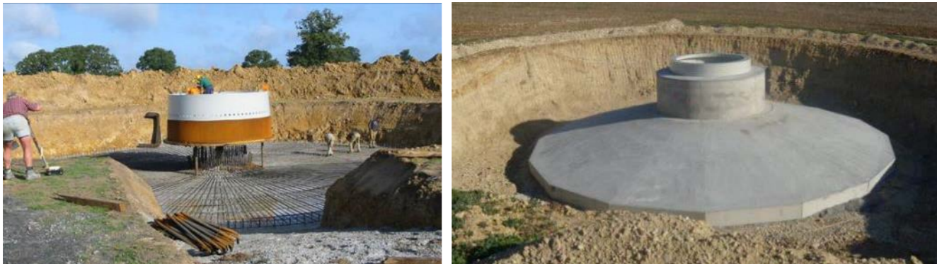
Le ferrailage et le coulage d'une fondation d'éolienne
