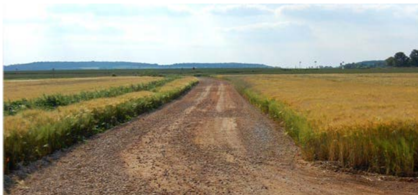
Exemple de voie d'accès à un parc éolien
