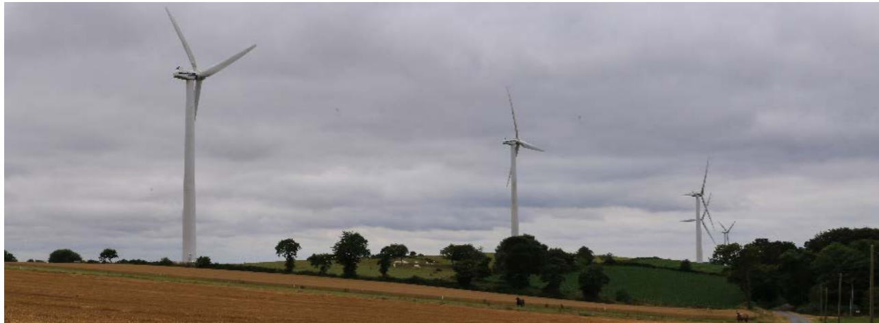
Parc éolien du Haut Corlay
