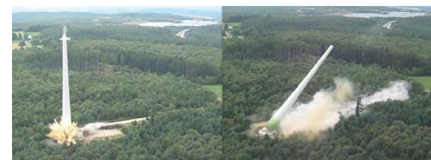
Figure 6: Dynamitage du mât en béton d'une éolienne
