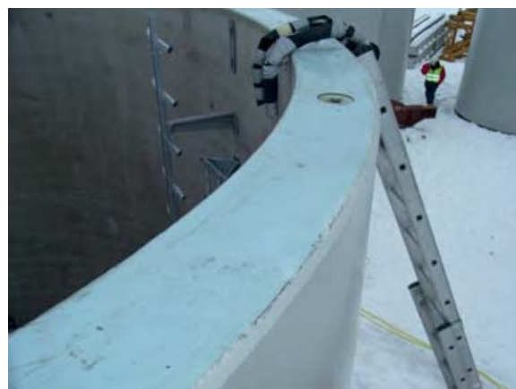
Figure 4: Le joint horizontal est aplani avec de la résine époxy et les sections sont placées les unes au-dessus des autres sans être collées
