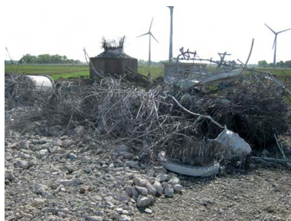
Figure 17: Armature en béton et en acier séparée
