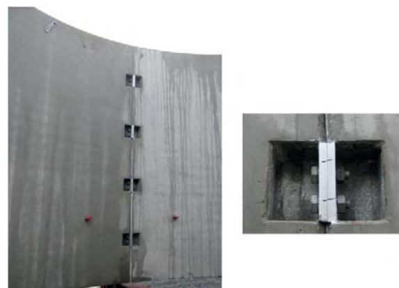
Figure 2: Le joint vertical est formé à l'aide d'un jeu de vis
