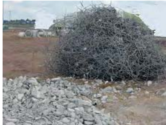
Figure 14: Béton et acier séparés
