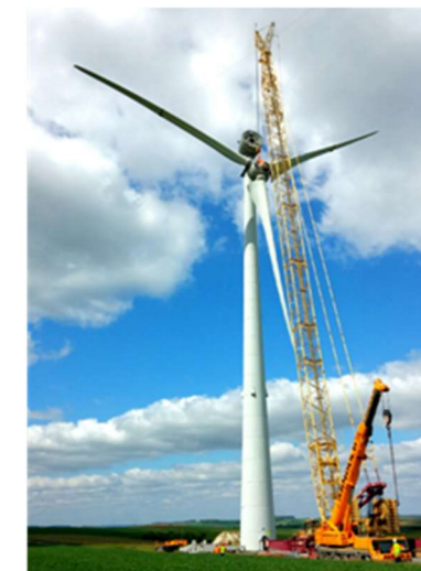
Figure 1 Levage du rotor d'une éolienne Enercon
