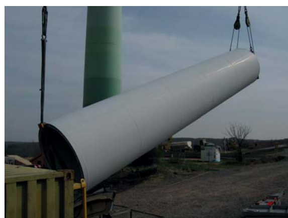
Figure 16: Déposer la section du mât
