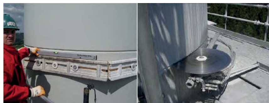
Figure 10: à gauche : Préparatifs pour la scie murale (paroi du mât), visser le rail de guidage sur la section / à droite : Commande hydraulique de la scie par une commande à distance
