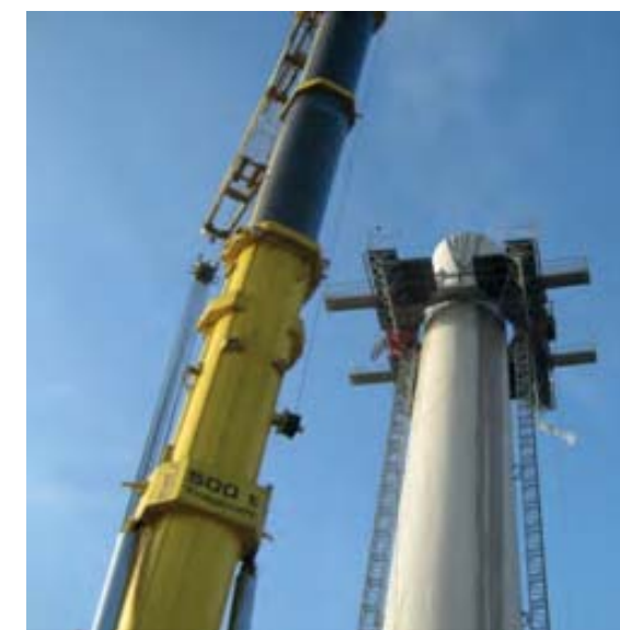
Figure 9: Plateforme de montage extérieure
