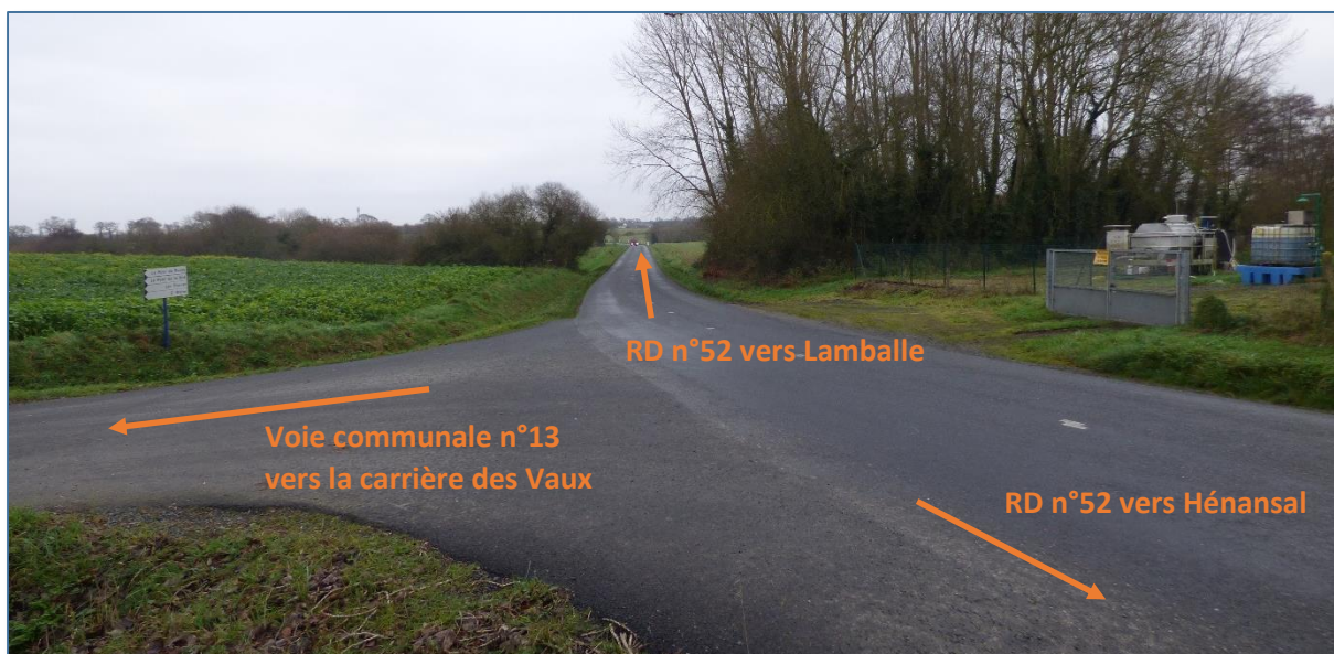
Fig. 17 : Vue 3 sur la voie communale n°13 aménagée pour le passage des camions (débouché sur RD 52)
