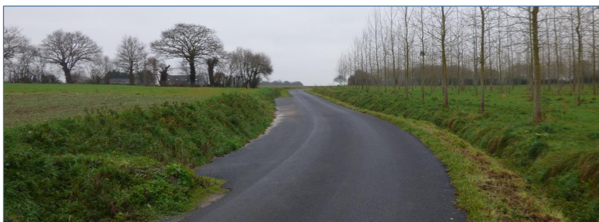
Fig. 16 : Vues 2a et 2b sur la voie communale aménagée pour le passage des camions (zones de croisement)
