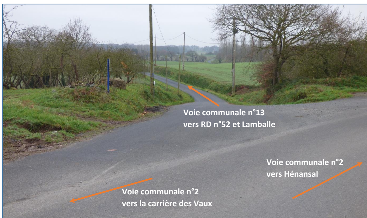
Fig. 15 : Vue 1 sur la voie communale aménagée pour le passage des camions (accès depuis le VC n°2)
