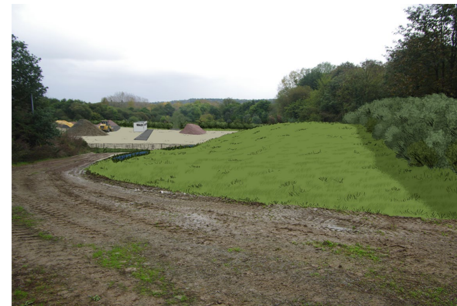
Situation après remise en état
